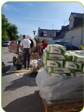
Préparation et protection espace de travail
