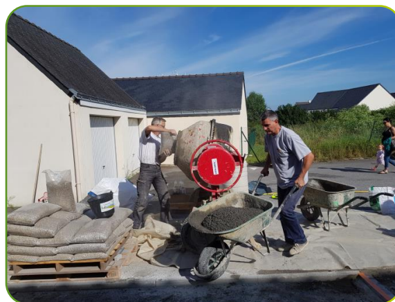
Déverser la préparation dans la brouette
