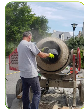
Verser 6 litres d'eau (seau gradué)
