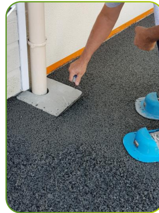
Finition des abords avec la truelle
