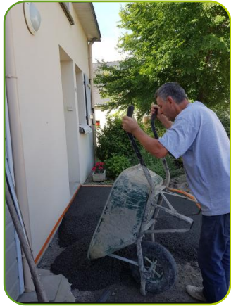
Déverser le Béton
