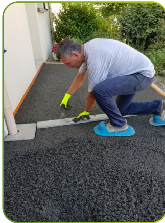
Création des joints de dilatation
