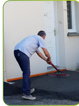
Serrer avec la lisseuse (Option)
