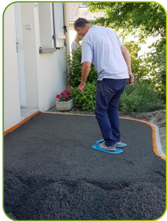
Serrer avec les Claquettes de finition
