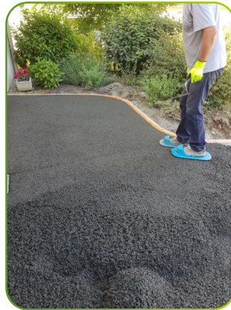
Finition du joint avec les claquettes
